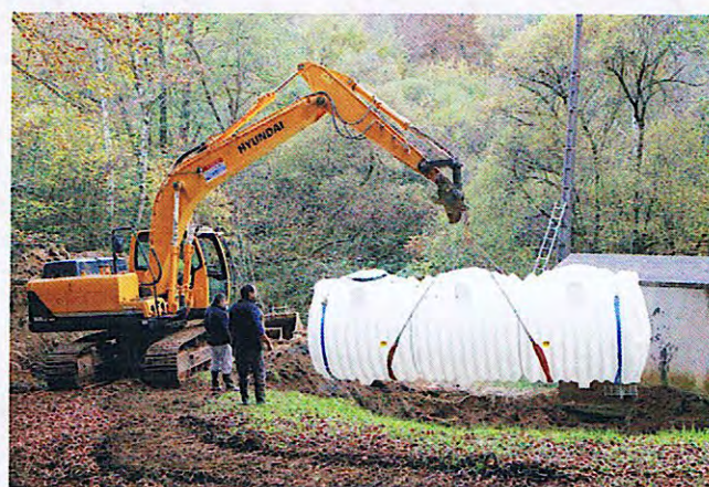
Travaux station de pompage Puyhabillier
